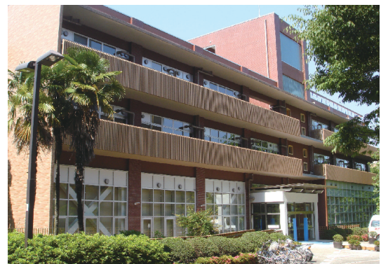
改修された医学部総合中央館
